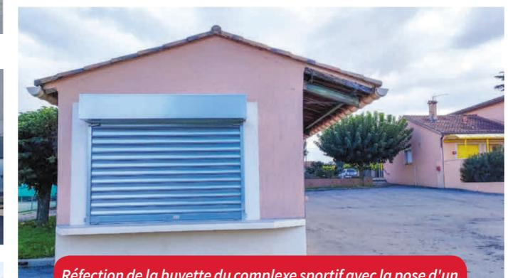
Réfection de la buvette du complexe sportif avec la pose d'un rideau métallique, travaux électriques à l'intérieur.
